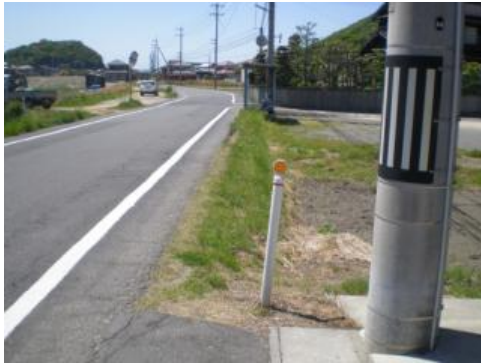
■対策前の状況
